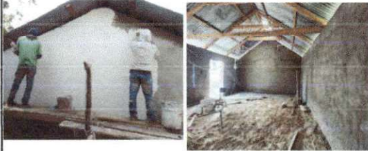
Foto 3: APLICACIÓN DE REPELLO Y CERNIDO
