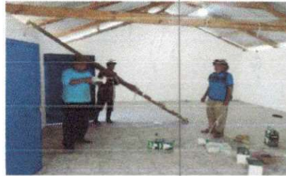
Foto 2: RENGLO 14, Reparacion de sistema electrico
